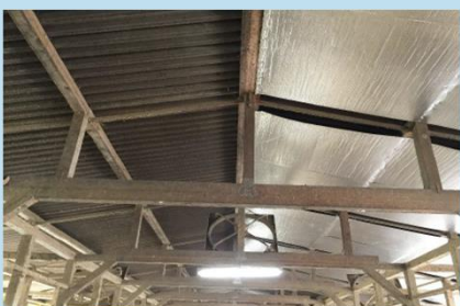
畜舎屋根裏への遮熱シートの施工
