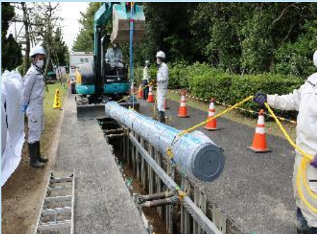
〔水道管路の更新・耐震化工事〕
