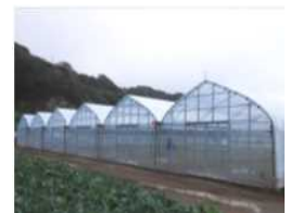
パイプハウス
