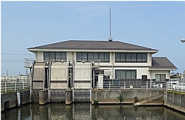
ポンプ場の整備
