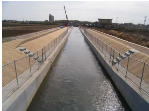
排水路の拡幅・かさ上げ
