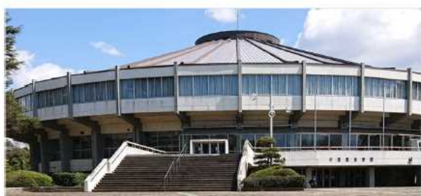
既存体育館 (外観)
