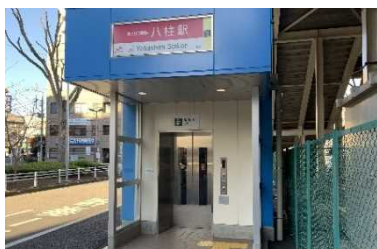
鉄道駅エレベーター
