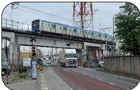
東武野田線（連続立体交差事業）
