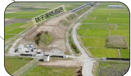
国道126号（銚子連絡道路）
