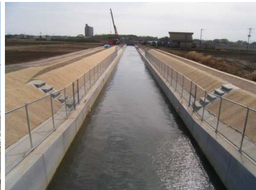
排水路の拡幅・かさ上げ
