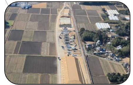
国道126号（銚子連絡道路）
