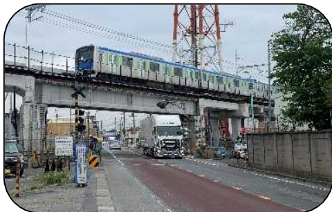
東武野田線（連続立体交差事業）
