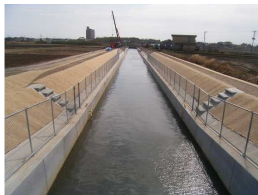
排水路の拡幅・かさ上げ
