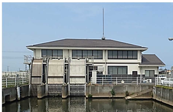
ポンプ場の整備
