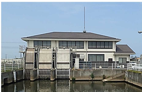
ポンプ場の整備
