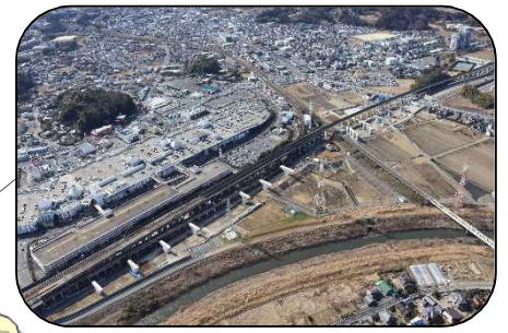
国道464号（北千葉道路）
