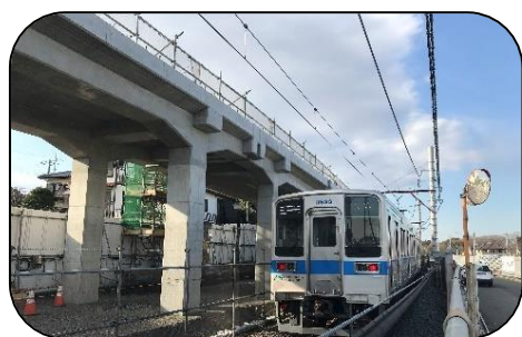
東武野田線（連続立体交差事業）
