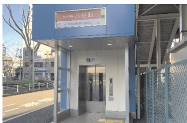
鉄道駅エレベーター
