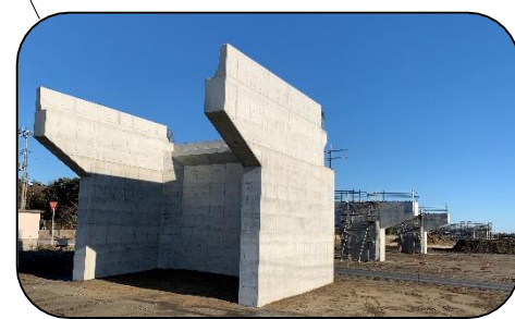
国道126号（銚子連絡道路）
