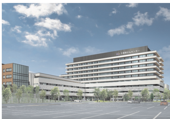
外観(既存病棟等解体後)
