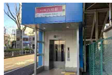
鉄道駅エレベーター
