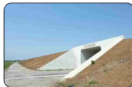
国道126号（銚子連絡道路）
