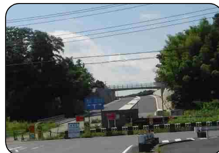
県道千葉鴨川線（高谷工区） （平成31年度開通予定）
