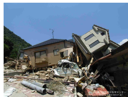
平成30年7月豪雨による住家被害 出典 (一財) 消防防災科学センター
