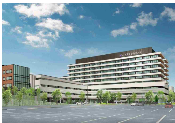
外観（既存病棟等解体後）
