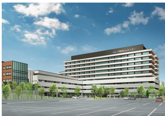
外観(既存病棟等解体後)
