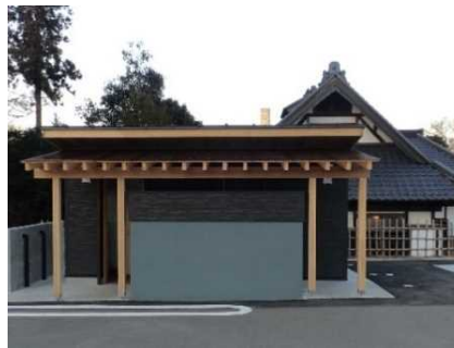
民間整備事例（H28 整備）
