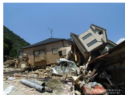
平成30年7月豪雨による住家被害 出典 (一財) 消防防災科学センター
