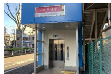
鉄道駅エレベーター
