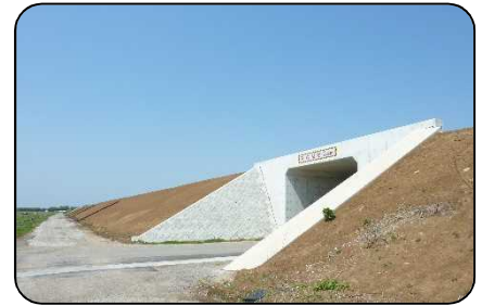
国道126号（銚子連絡道路）
