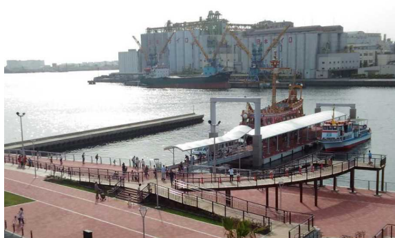
【浮棧橋（1基目 平成28年オープン）】
