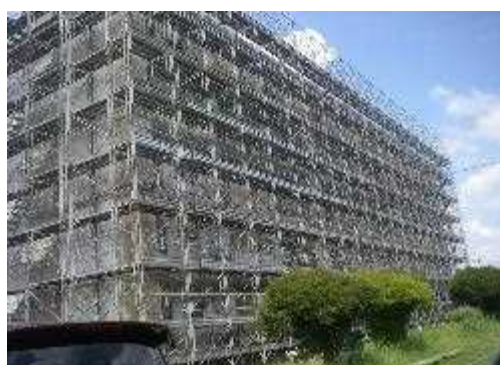
<改修工事の様子>
