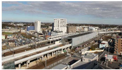
新京成線連続立体交差事業
