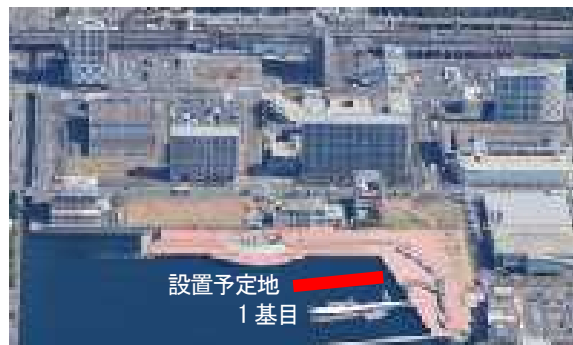
【2基目 設置予定地】
