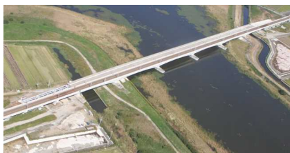
北千葉道路印旛沼渡河橋（印西市）
