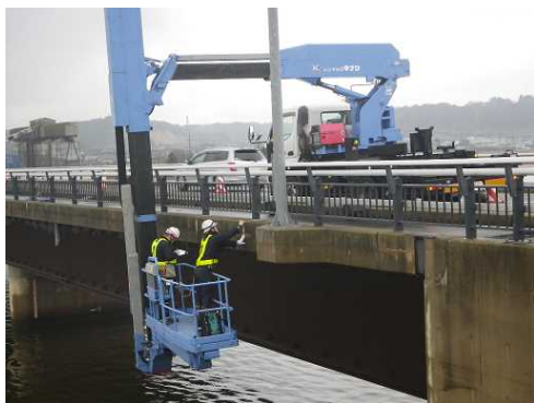
橋りょう（点検車）
