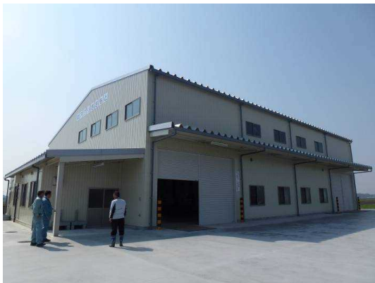
乾燥調製施設の外観
