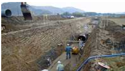
用水路の整備
