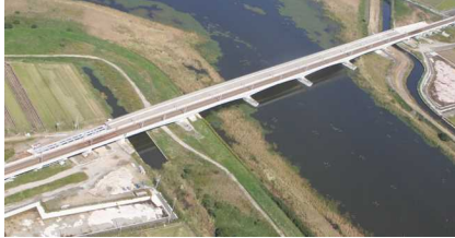
北千葉道路印旛沼渡河橋（印西市・建設中）
