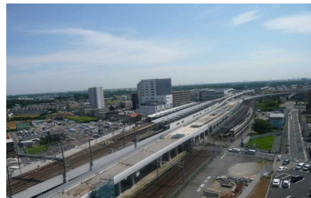
新成線新鎌ヶ谷駅付近の高架橋施工状況
