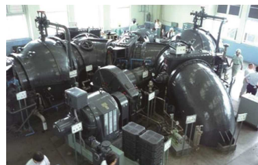
排水ポンプの改修
