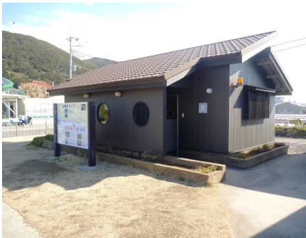
整備事例（館山市 H25 整備）
