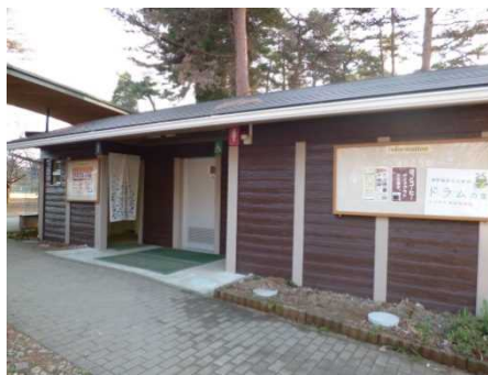
整備事例（栄町 H26 整備）
