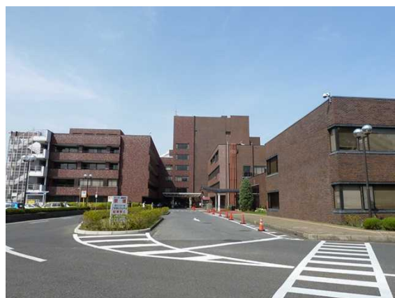
<現在のがんセンター（正面外観）>
