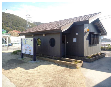
整備事例（館山市 H25 整備）
