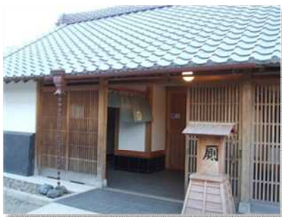
整備事例（香取市 H21 整備）
