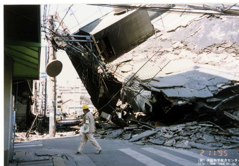
※阪神淡路大震災により道路が閉塞された様子
