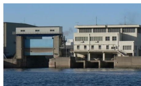
水門・排水機場の改修整備
