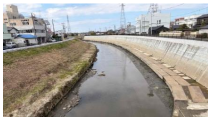
河道拡幅・護岸整備
