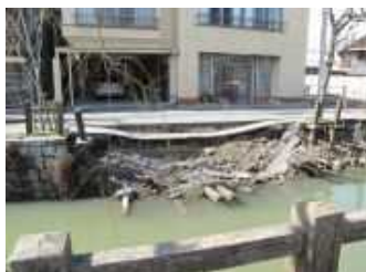
崩落した道路・護岸の復旧(香取市)
