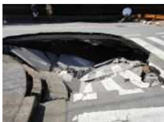
液状化により陥没した道路の復旧(習志野市)
