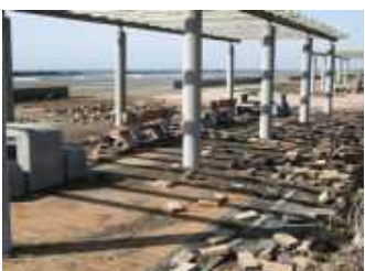
津波被害を受けた海水浴場施設の復旧(旭市)
