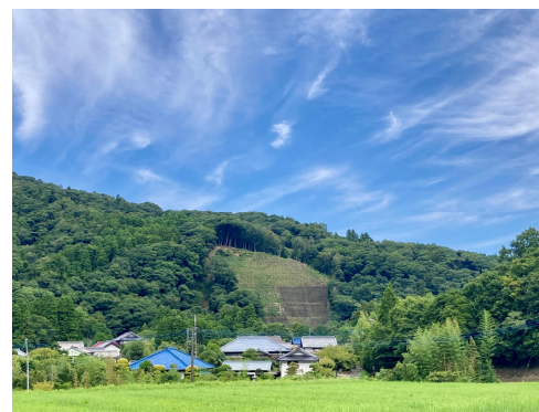
例) 山崩れや地すべり被害地の復旧
