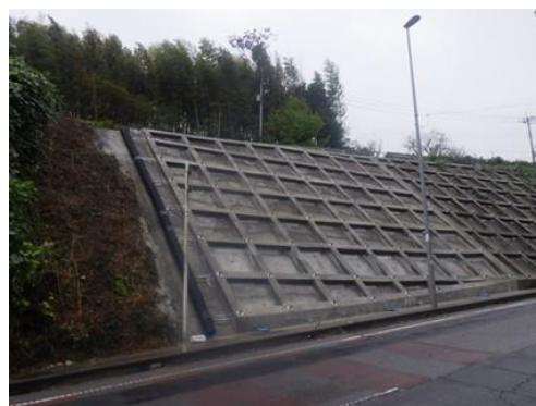
例) 道路法面工事
