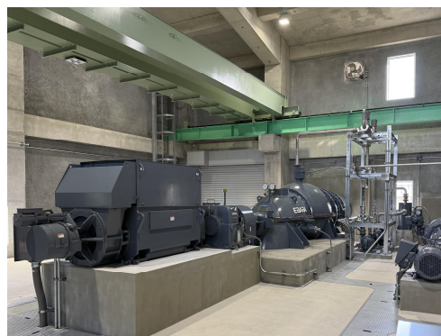
例) 排水機場の整備
