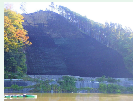
例) 山崩れや地すべり被害地の復旧
