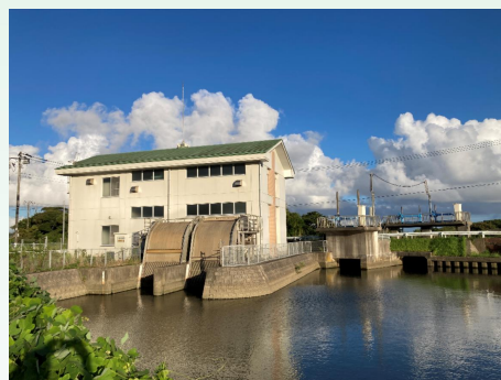
例) 排水機場の整備
