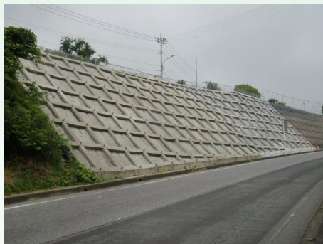
例) 道路法面工事
