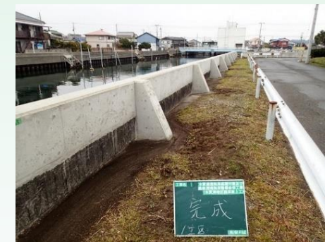
例) 護岸の嵩上げ整備
