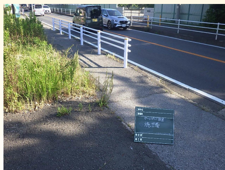
例) 防護柵の設置
