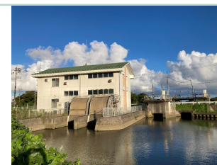
例) 排水機場の整備
