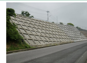
例) 道路法面工事
