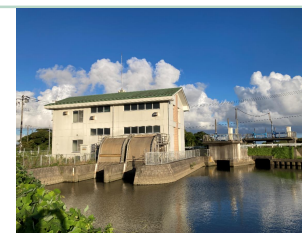
例) 排水機場の整備
