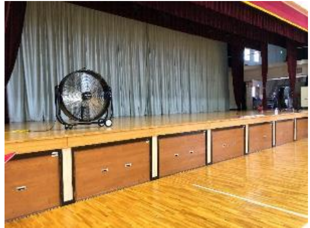
体育館に大型送風機を設置
