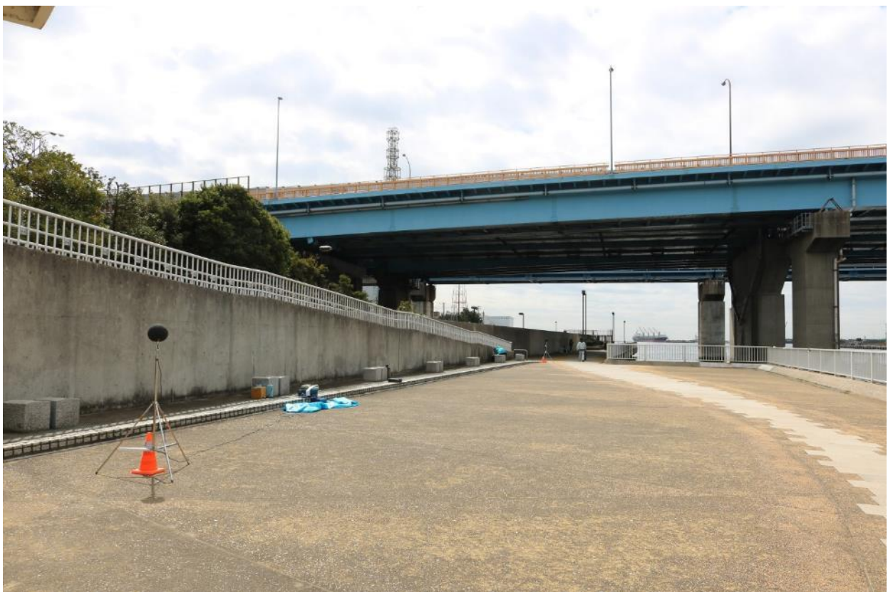
写真4 地点② (高架橋全景, 4.0m位置から見た0m位置方向)
