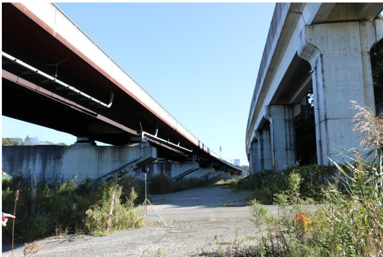
写真7 地点③（高架橋全景と測定位置）
