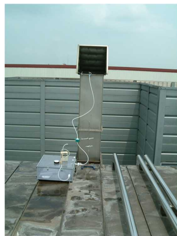
写真4 排気塔からガスを吸引
