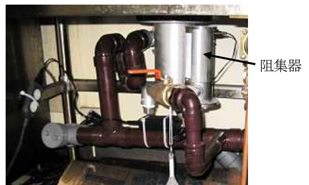
図1 コンビニ設置阻集器（シンク下）
