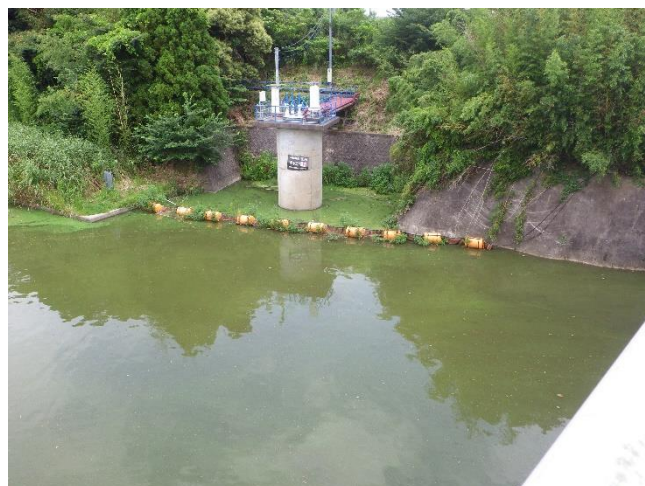
図 4 地点 7（境橋右岸下流）周辺
