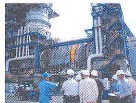
写真④ ロータリーキルンの説明の様子
