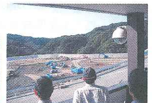
写真⑤ 処分場の様子
