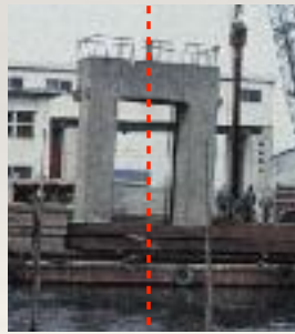
傾いた水門 1971年 市川市
