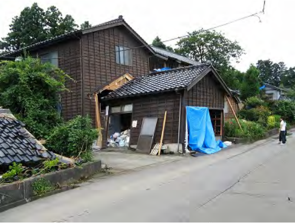
図3 柏崎市長崎（北緯 37 度 23 分 52 秒，東経 138 度 35 分 55 秒付近，沼の西側斜面上の家屋の多くは大きな損傷を受けた。）
