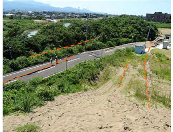
図6 柏崎市山本付近に発生した地滑り（北緯 37 度 23 分 38 秒，東経 138 度 35 分 5 秒付近，点線は亀裂の位置。）
