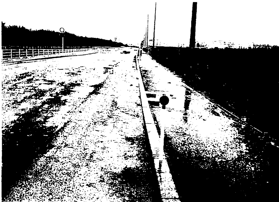
図5 竹之内団地西端の道路の補修とその後の変形（2001年1月撮影）
