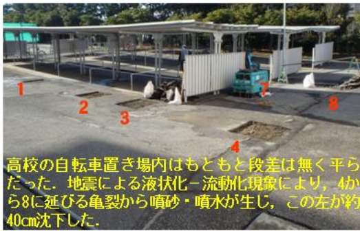
写真2 学校内の被害と地層採取地点（番号は地層採取地点で図2・図3の番号と同じ）
