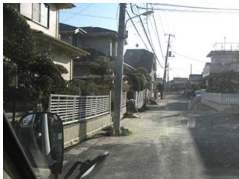
写真16 千葉市美浜区真砂 噴砂と塀の傾き(3/13)。
