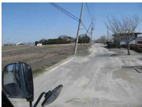
写真30 神崎町神崎新宿 旧河道よりも北側でも旧河道に平行に亀裂が走りここからの噴砂がみられる。また、地波、電柱の傾き・沈み込みがみられる(3/19)。
