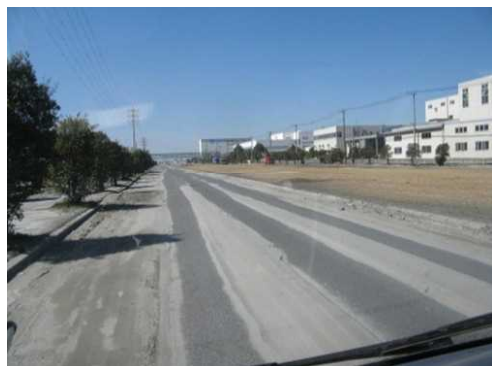
写真24 船橋市高瀬町 広範囲に噴砂がみられた(3/18)。
