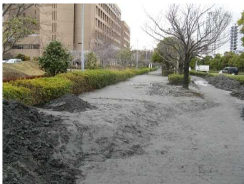
写真22 浦安市明海 噴砂は50cmもの厚さで堆積したところがある(3/23)。
