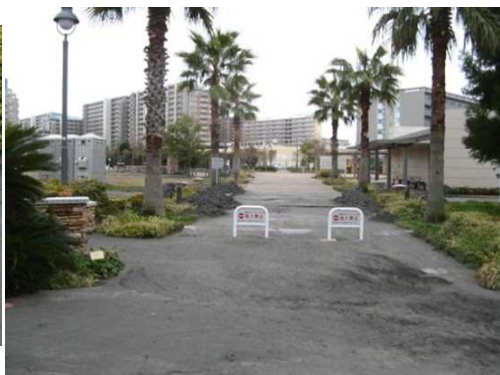
写真21 浦安市日の出 おひさま公園では、写真手前は噴砂や沈下が著しいものの、奥のほうではほとんど被害はみられていない(3/23)。
