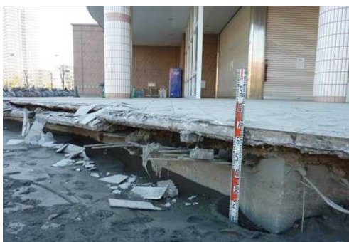
写真17 浦安市明海 噴砂と沈下による抜け上がり(3月中旬)。
