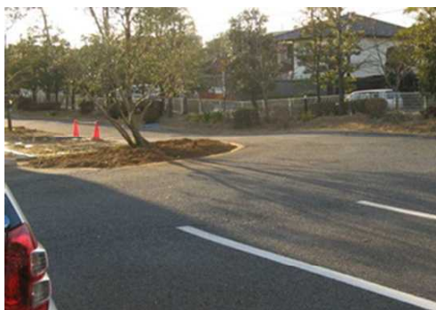
写真14 千葉市美浜区磯辺 局所的な細長い沈下がしばしばみられた(3/12)。
