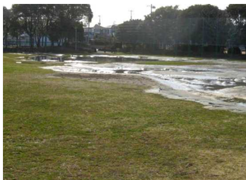
写真15 千葉市美浜区磯辺 中磯辺公園での大規模な噴砂と大規模な沈下(3/12)。
