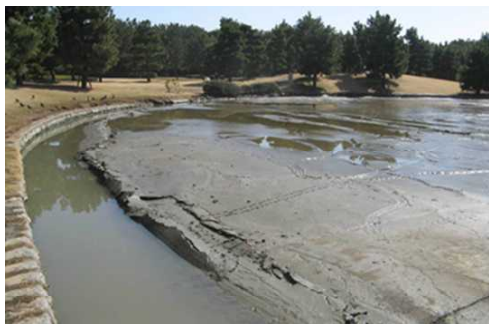
写真11 千葉市美浜区高浜 大量の噴砂で埋まった稲毛海浜公園内の池。築山部分では噴砂は出ていない(3/12)。
