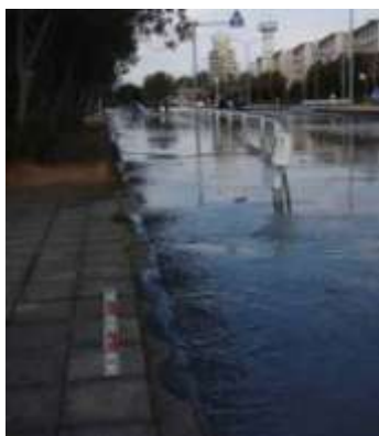
稲毛地区前の車道。車道と歩道の境界から噴砂・噴水が長時間続き、車道は広い範囲に浸水した。3/11 15時27分撮影。
