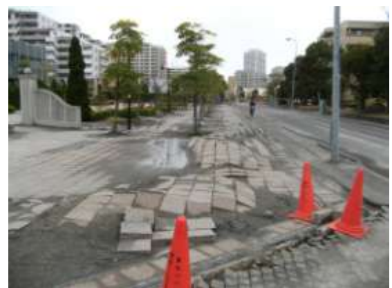
日の出 歩道の波うち, 凹凸の高さは40cm程度。
