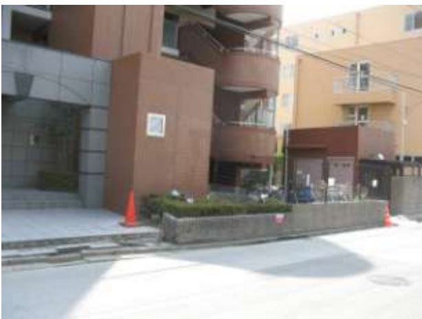
今川 構造物の抜け上がりは20cm程度
