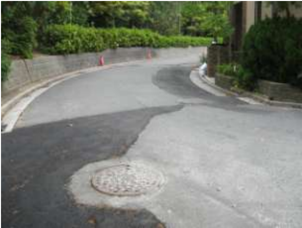
舞浜 道路の右カーブの内側が 20cm 程度沈下した。
