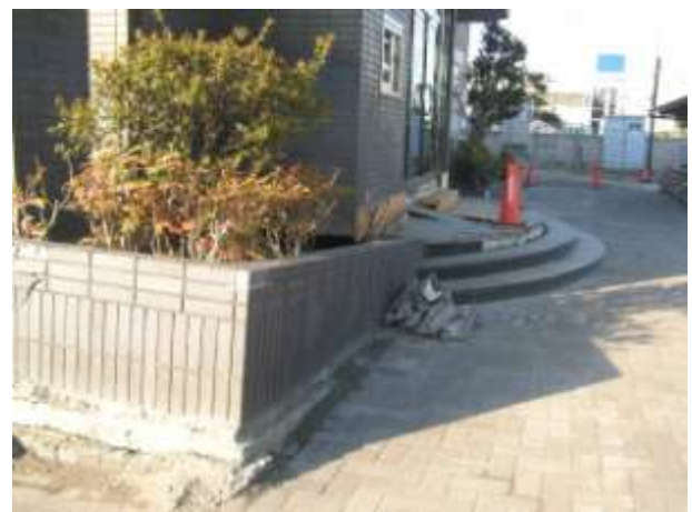
鉄鋼団地 入口のコンクリート階段が沈み込んだ。
