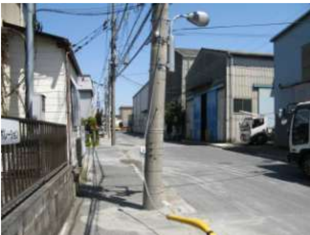
鉄鋼団地 電柱が数 m 沈み込んだ。
