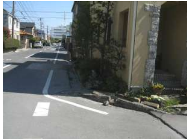
舞浜 道路の右カーブの内側が 20cm 程度沈下した。
