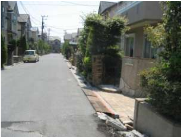
舞浜 宅地部分が 20cm 程度沈下した。レンガ塀も 20cm 程度沈み込んでいる。
