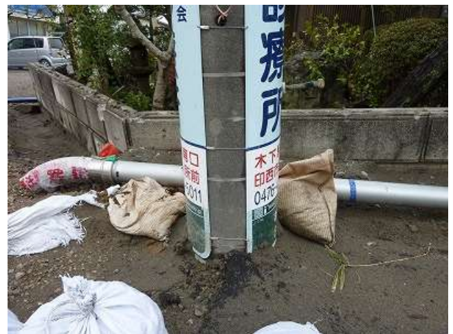
都：沈み込んだ電柱。電柱の際から噴砂が見える。
