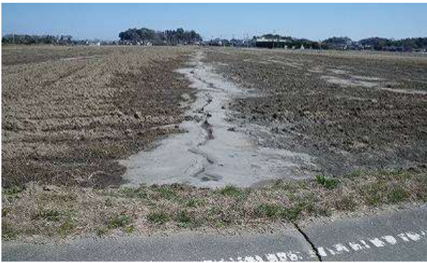
直線状の亀裂（東向きに撮影）。
