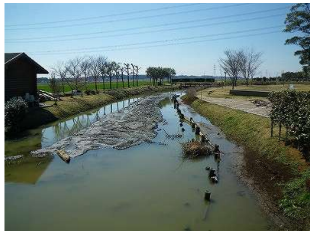
同左の水路中央付近は、川底からの噴砂で盛り上がっている。
