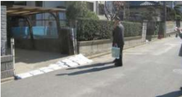
ブロック塀の傾き・沈み込み (数十 cm) がみられる。
