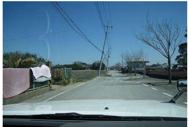
噴砂の見られる周辺では、電柱が傾斜している。
