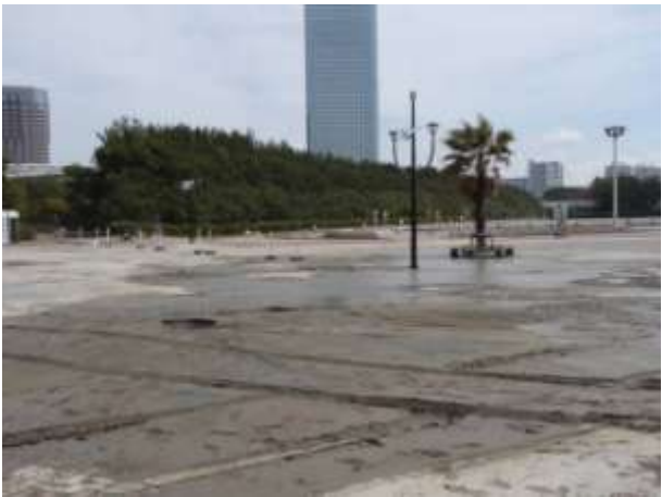
スタジアムの北側から東側にかけて噴砂がでている。マリスタジアム駐車場入り口は一面に噴出した砂が広がり、原付自動車がタイヤ半分の高さまで砂で埋もれていた。
