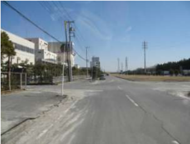
液状化ー流動化による地表面の変形。電柱の傾動（先端が黄色の電柱が被災したもの）。
