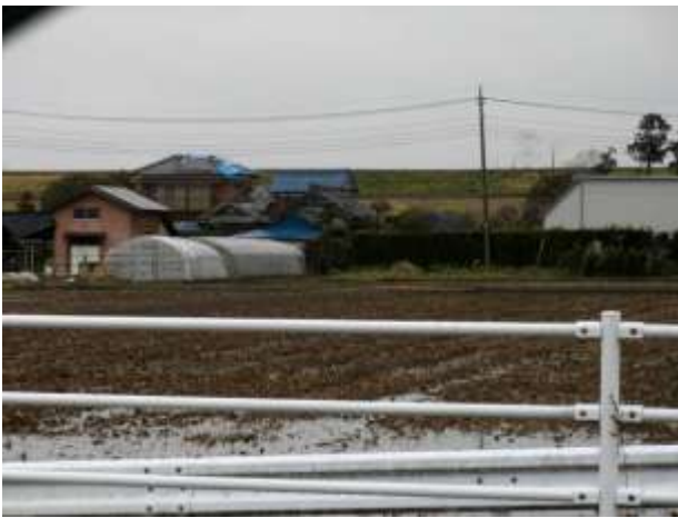
中谷：堤防の損傷がみられる近くでは瓦屋根の被害もみられる。
