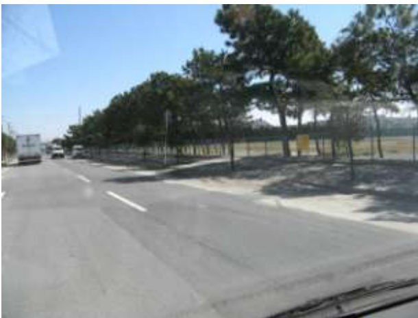
運動公園周辺では直径数十 m の大規模な噴砂が多くみられる。
