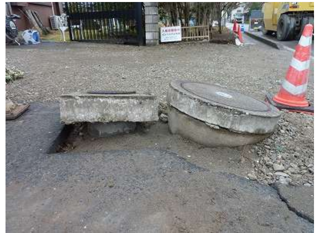
都：き上がったマンホール。
