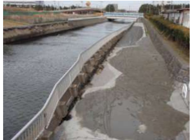
茜浜と海浜霊園の間にある菊田川の水路左岸。左岸側では液状化した噴砂が認められ柵が波打ち水路側に張り出している。
