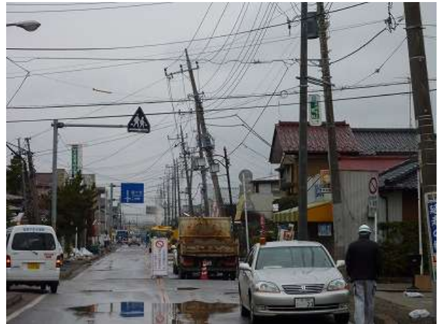
都：前写真の反対側から液状化被害地を見る。
