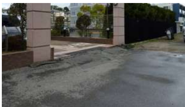
高速道路側道に面した側道と反対側のマンション入り口。抜けあがっている。
