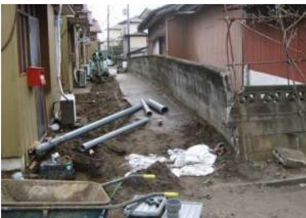
布佐酉町：道路の変形と家屋・塀の傾き。
