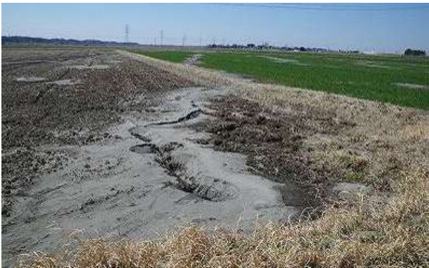
直線状の亀裂（西向きに撮影）。
