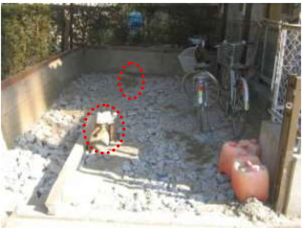
ブロック塀の傾き・沈み込み (数十 cm) がみられる。
