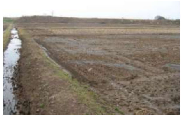
旧河道の流路に平行な亀裂が何列も走り、噴砂を生じている。
