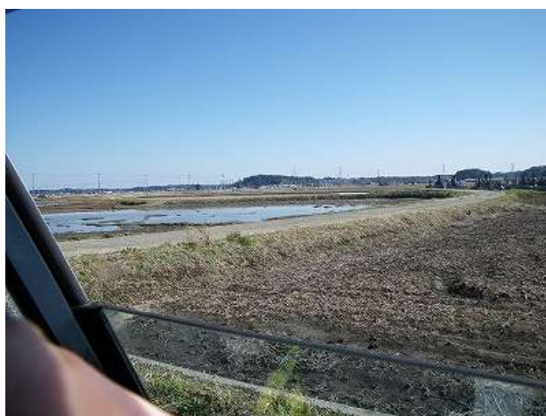
大貫飛地では液状化—流動化により地盤沈下し、水が溜まっている（墓地の東側）。
