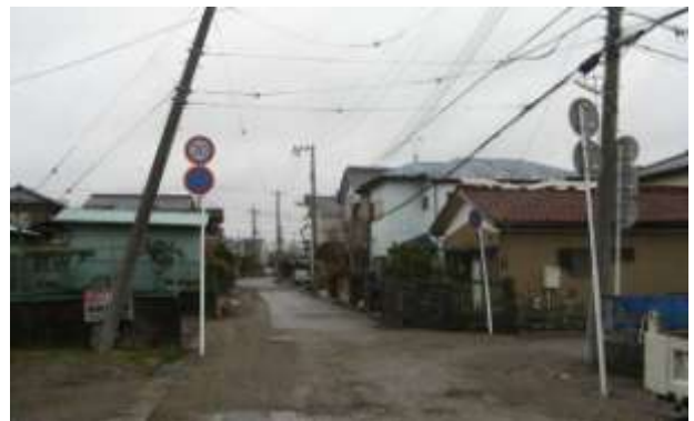
布佐酉町：道路の変形と家屋・塀・電柱の傾き・沈み込み。
