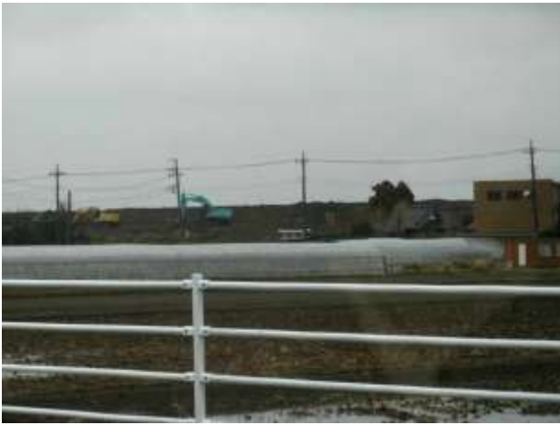
中谷：利根川の堤防の損傷の復旧工事。
