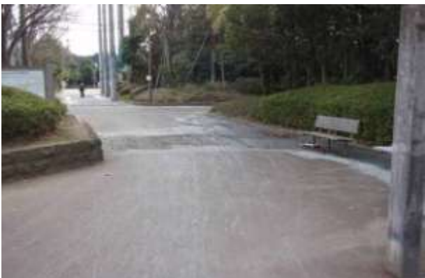
噴砂は認められるが、電柱の傾倒はない。南部の秋津総合公園では、噴砂は認められるが、噴出する砂の量
