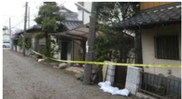
布佐酉町：道路の変形と家屋・塀の傾き。深刻なところ
