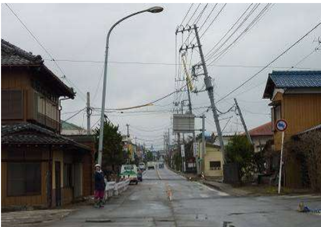
都：液状化被害地の様子。電柱の落ち込み・傾き、道路の変形、家屋の傾動・損壊など被害は大きい。都 噴砂とともに建屋やブロック塀・電柱などの構造物の沈み込みや傾きが 50 軒以上みられる。中には 1m 程度
