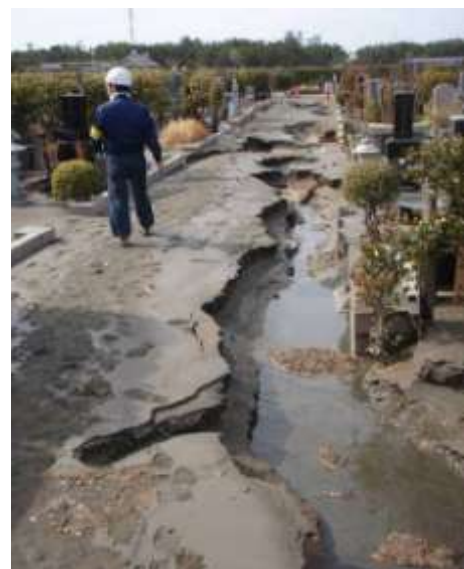
茜浜と海浜霊園の間にある菊田川の水路左岸。左岸側では液状化した噴砂が認められ柵が波打ち水路側に張り出している。
