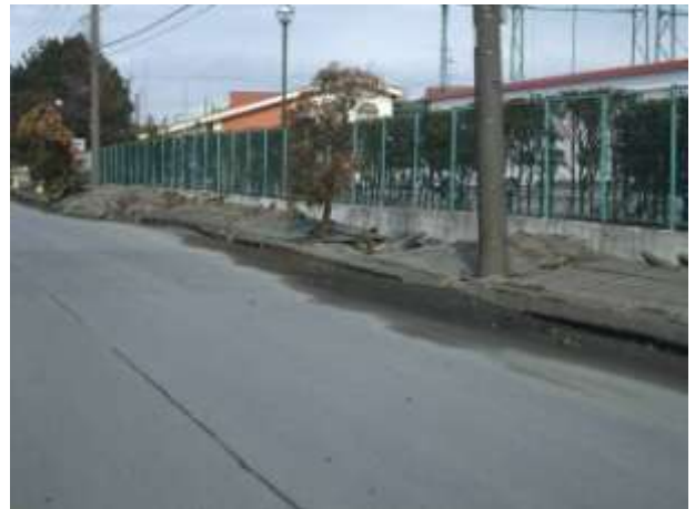
液状化ー流動化による地表面の変形。電柱の傾動（先端が黄色の電柱が被災したもの）。
