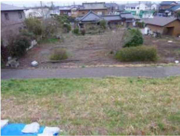
都：堤防の損壊箇所から被害地住宅地を見る（写真手前に堤防の損壊箇所を覆うビニールシート。中央に見える畑には堤防と並行の亀裂・及び噴砂が見える。その奥が液状化・流動化による被害住宅地。
