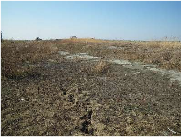
亀裂と帯状につながる噴砂口列。
