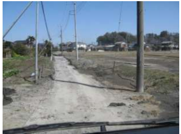
神崎町神崎新宿：液状化→流動化に伴う大量の噴砂と地波、電柱の沈みこみ
