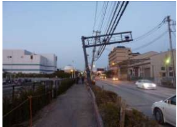
U-3 浦安市での大量の噴砂と道路施設の柱の傾動
