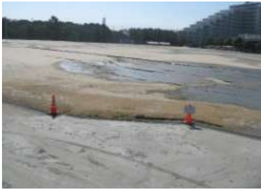
C 帯-3 高浜 3 丁目稲毛高校 長い亀裂に伴う噴砂と沈下
