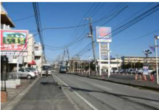
B帯-3 稲毛海岸1丁目 電柱の沈降・傾動
