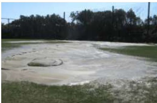
C 帯-3 高浜 3 丁目稲毛高校 長い亀裂に伴う噴砂と沈下
