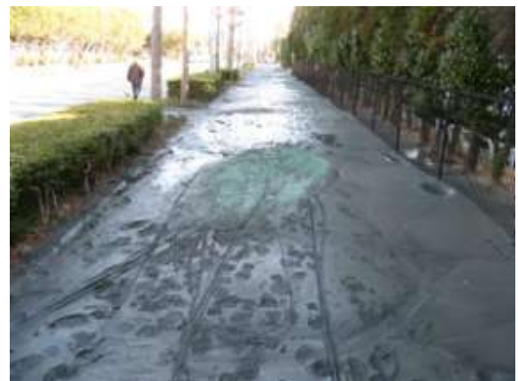
C帯-1 稲毛海岸3丁目 数十mの亀裂を伴う大規模噴砂
