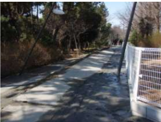
H 帯-2 袖ヶ浦での噴砂と地表の変形，電柱の傾動
