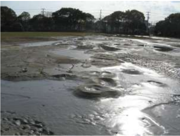
E 帯-1 磯辺 7 丁目での噴砂と地盤の変形
