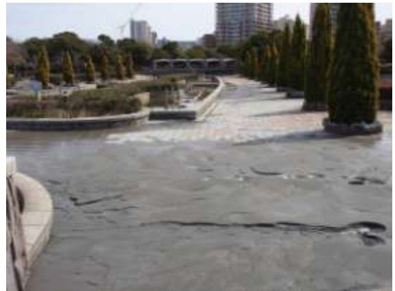
E 帯-1 磯辺 7 丁目での噴砂と地盤の変形
