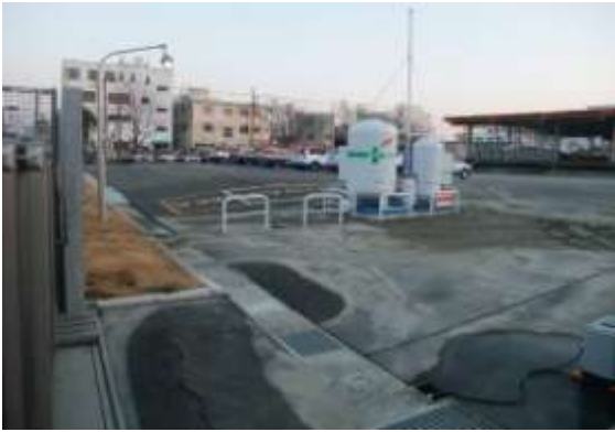
B帯-1 新港における地下タンクの浮上と噴砂
