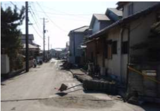
H 帯-1 香澄での噴砂，電柱の傾動，塀の倒壊
