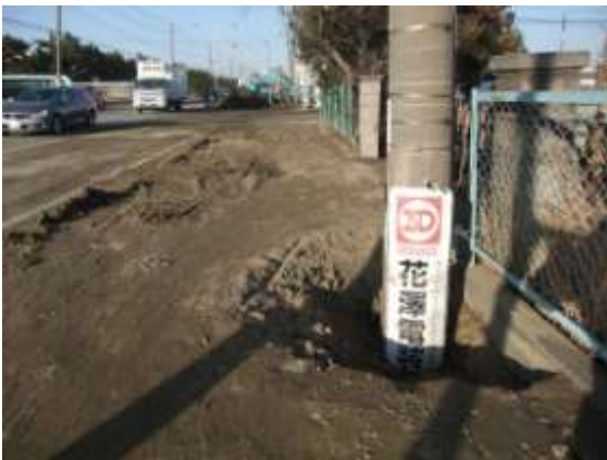
B帯-2 新港 電柱の沈降と大量の噴砂
