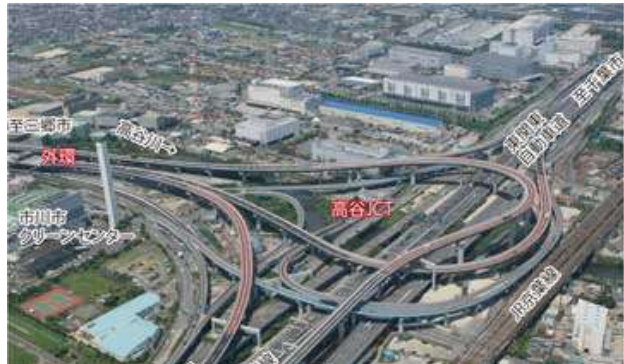
写真-⑦-1 東京外かく環状道路 千葉県市川市高谷付近（高谷JCT付近）
