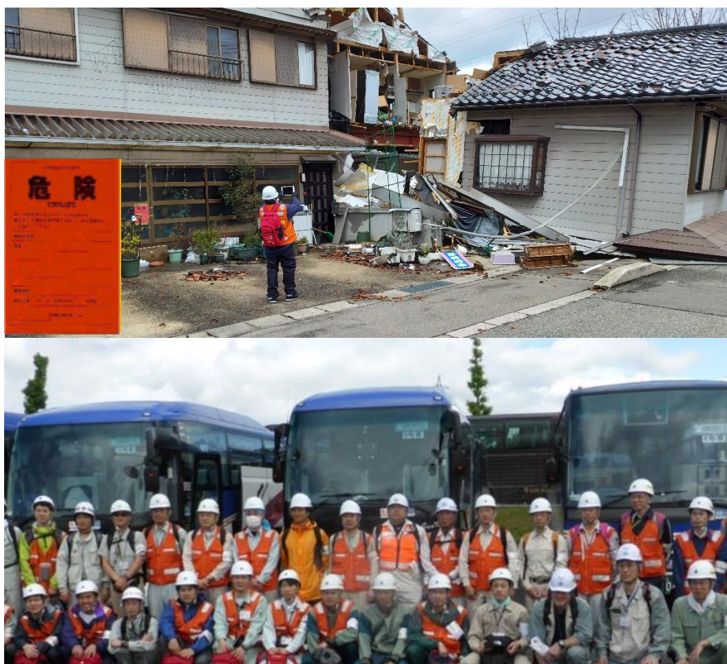
図-15-1 被災建築物応急危険度判定
