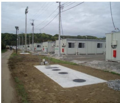
図-15-5 応急仮設住宅（建設型）設置状況 (旭市：東日本大震災による)
