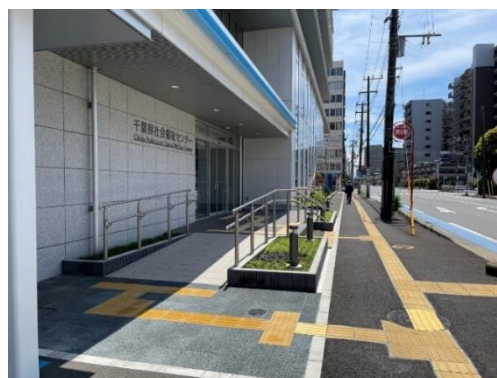
千葉県社会福祉センター（注意喚起用床材、誘導用床材及びスロープ）
