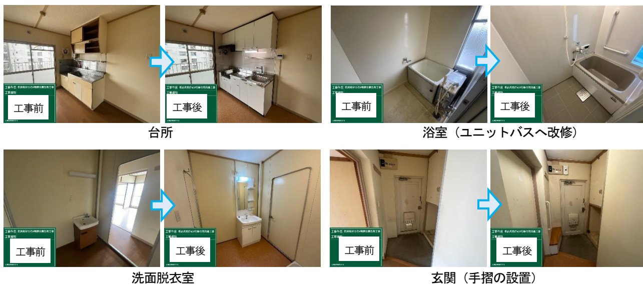
長浦県営住宅住戸改善工事写真 令和6年度(2024)完成
