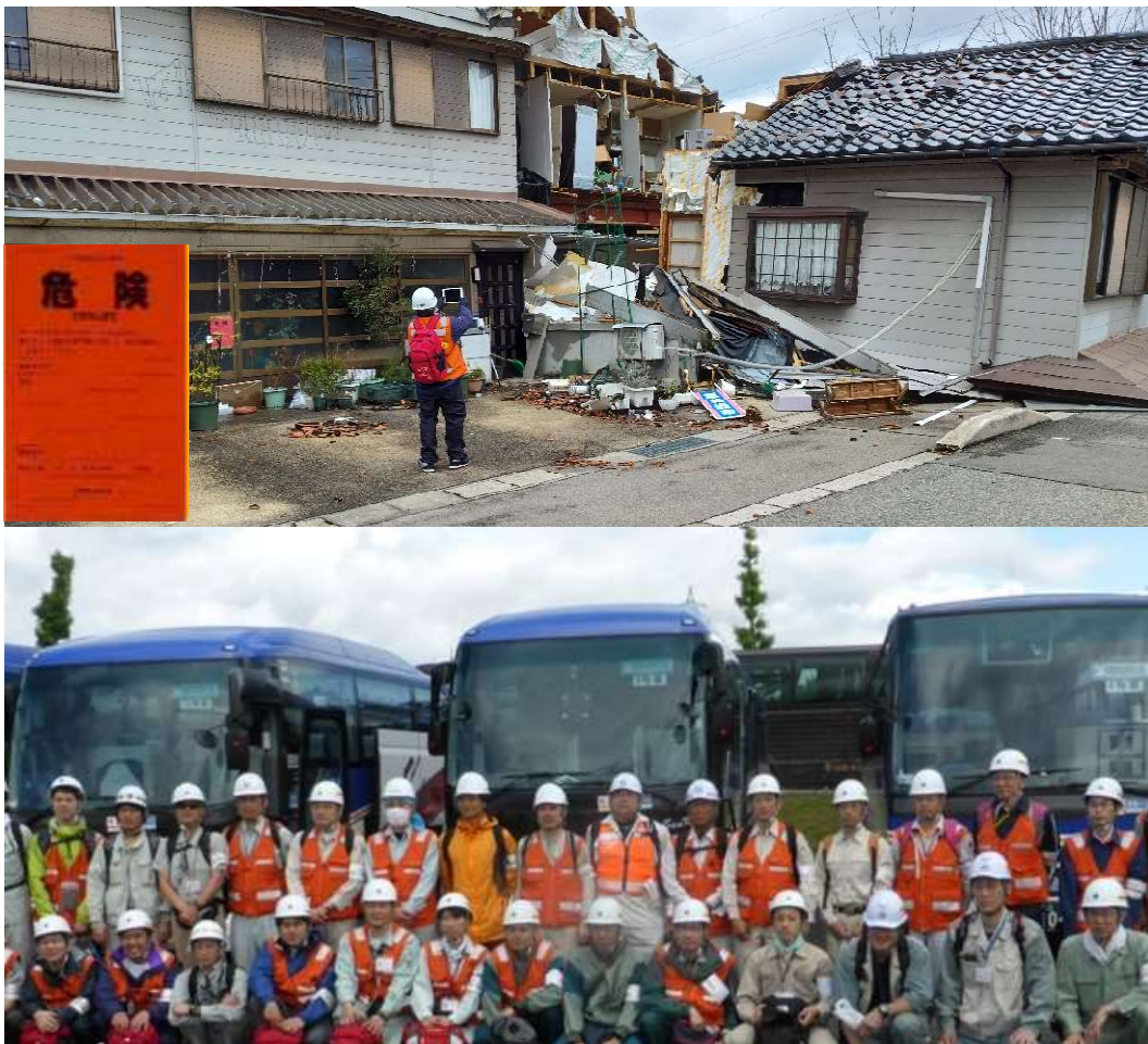
図-16-1 被災建築物応急危険度判定
