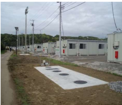
図-16-5 応急仮設住宅（建設型）設置状況 (旭市：東日本大震災による)
