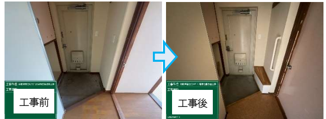
玄関（手摺の設置）
