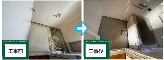
浴室（ユニットバスへ改修）
