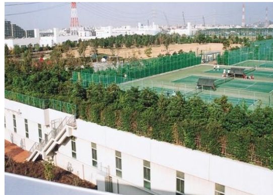
江戸川第二終末処理場の上部利用 (市川市 福栄スポーツ広場)
