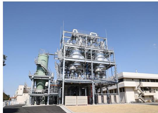
下水汚泥固形燃料化施設 (市原市 松ヶ島終末処理場)
